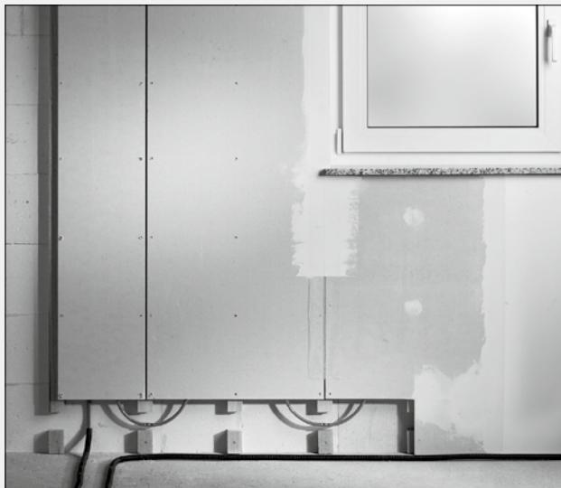
Sustav zidnog grijanja za suhu unutarnju izgradnju kod renoviranja i u novogradnjama. Cjevovodi od polibutena 12 x 1,3 mm su već integrirani u zidnu ogrjevnu ploču, tako da nisu potrebni nikakvi dodatni radovi s masom za ispunu. Montaža se vrši na prikladnoj podkonstrukciji odn. direktno na metalnim potpornjima kod suhih zidova.
